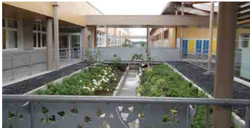
À l'École Régionale pour Déficients Visuels (ERDV) Ignace Pleyel de Loos (59) une signalisation «sensitive» et «auditive» a été mise en place à la fois par différents revêtements sur les passerelles (bois, métal, pierre) et par la création de venelles avec cascades d'eau de diverses hauteurs.
