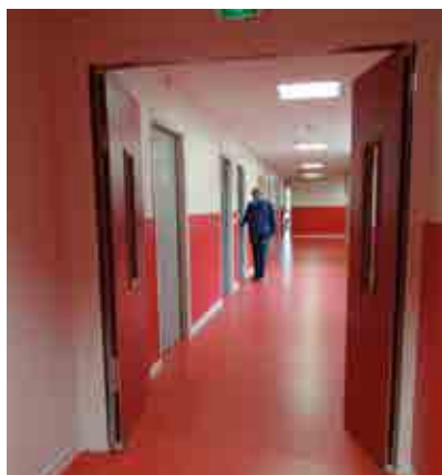
Porte coupe-feu de recoupement (couloir)
