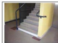
Garde-corps et rampes
